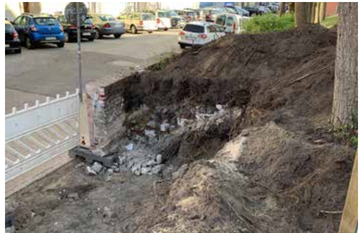
Freigelegt: ehemalige Treppenanlage zur Noblestraße
